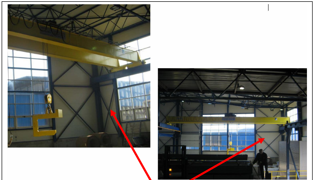
Vertikalni spregovi u kalkanskom zidu
