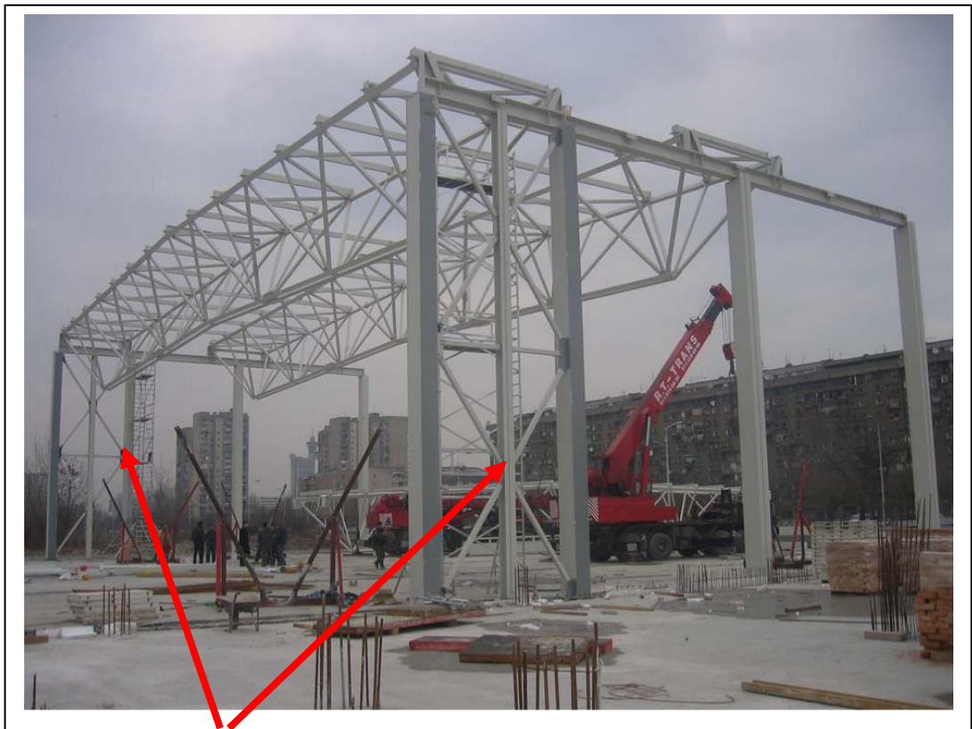
Vertikalni spreg u podužnom zidu
